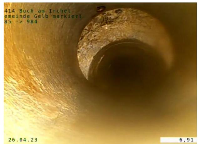
Abbildung 32 Muffen versetzt
