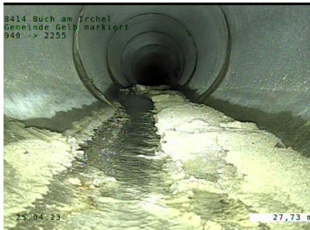
Abbildung 29 Kalkablagerungen 4 bis 8 Uhr
