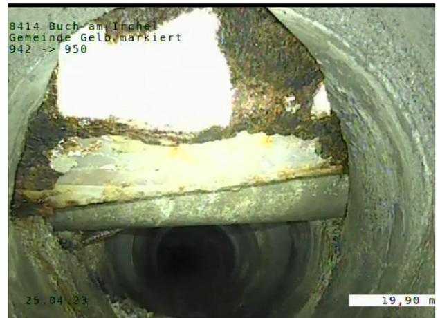
Abbildung 30 Rohr gebrochen, Bodenmatte eindringend
