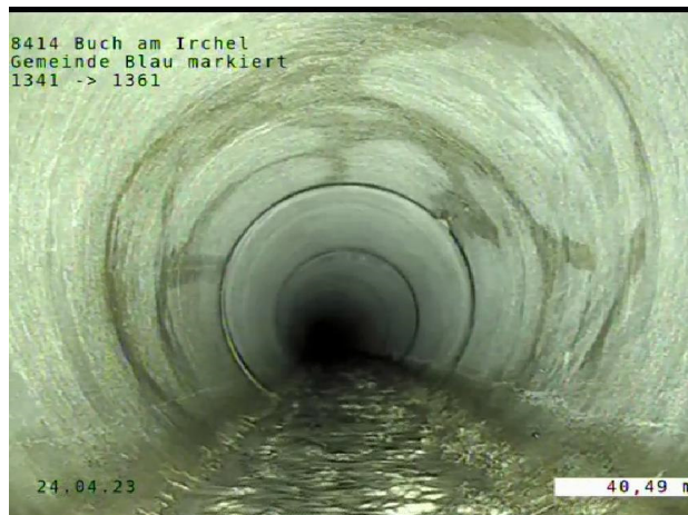
Abbildung 21 Kalkablagerungen 4 bis 8 Uhr
