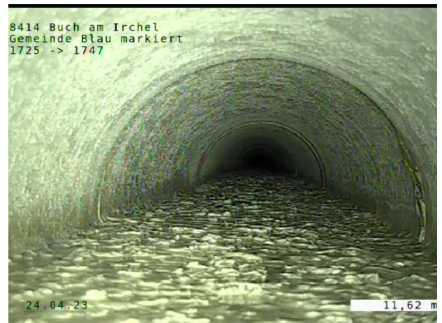
Abbildung 22 Kalkablagerungen
