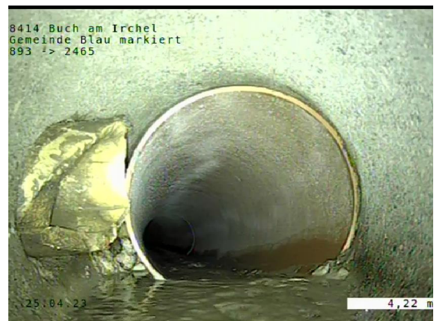
Abbildung 24 Anschlüsse einragend
