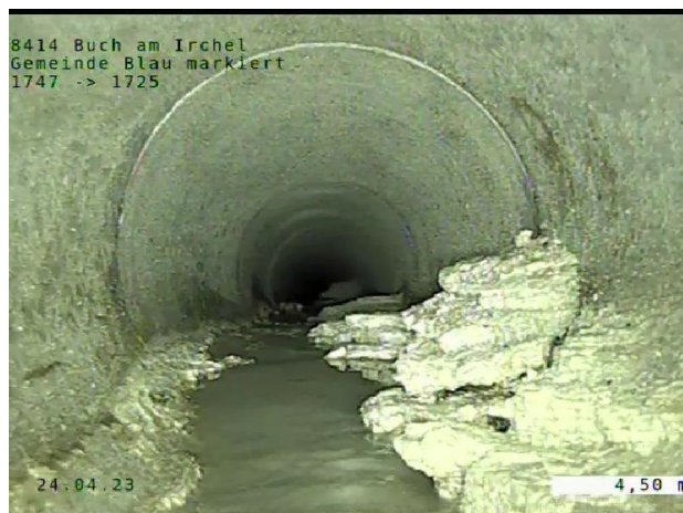
Abbildung 23 Kalkablagerungen
